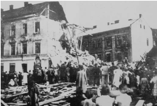
zniszczone domy na Targowicy
